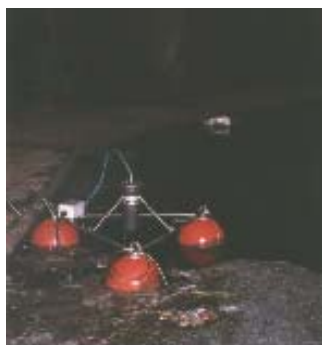
Oilspy sur bouée de bassin en chambre de dessablement
